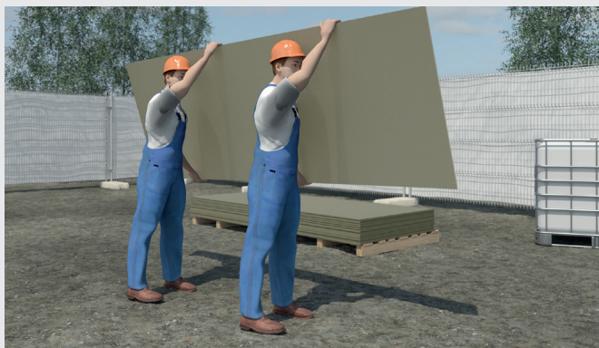
Bær altid Hardie® Shield vindplade på højkant
