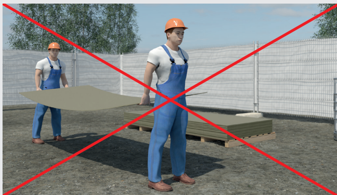
Bær altid Hardie® Shield vindplade på højkant
